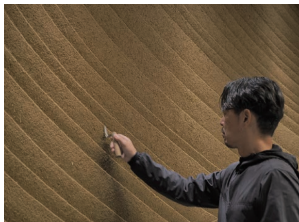
箱根・富士屋ホテル「レストラン・カスケード」の大壁施工時
