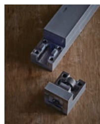
新設鉄骨の仕口
