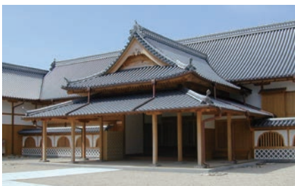
佐賀城本丸御殿復原 玄関・式台
