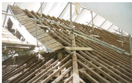
南水会館解体 野隅木が棟まで伸びる
