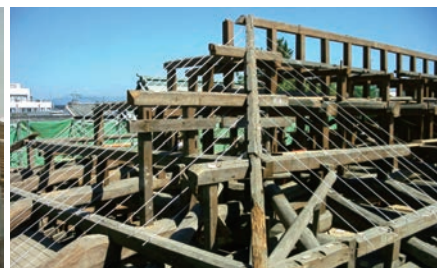
入母屋を外し寄棟の野垂木を確認
