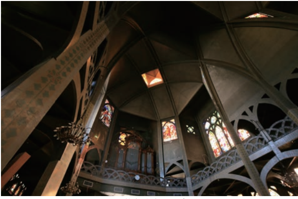
サン＝ジャン・ド・モンマルトル教会 室内見上げ (撮影：後藤武)
