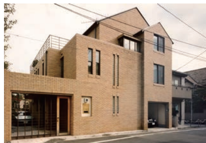
渡辺武信設計室時代に担当した池田山の家 しゃもじ型プラン、切妻屋根、シャモット二丁掛タイル、天井高さ2250mm、開口は天井まで…がアイコンでした。
