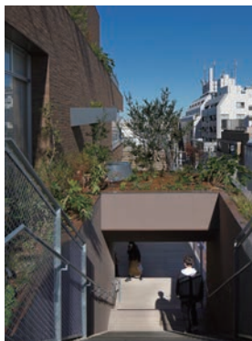
雨水はガーゴイルを介してバードバスに集水される
