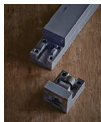
新設鉄骨の仕口
