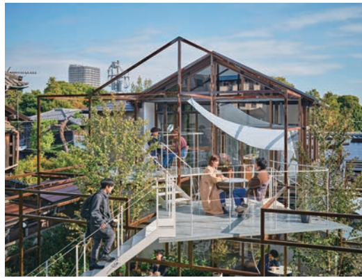
左：戦前棟より庭を見る 右：新設鉄骨フレームによるテラス
