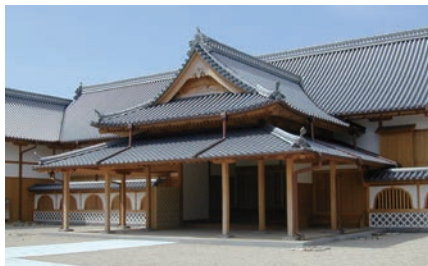
佐賀城本丸御殿復原 玄関・式台
