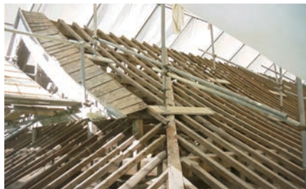
南水会館解体 野隅木が棟まで伸びる
