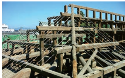
入母屋を外し寄棟の野垂木を確認
