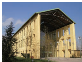
砂糖工場を転用したバガニーニ音楽堂。1899年から1968年まで稼働し、2001年改修。設計はレンゾ・ピアノ。(筆者撮影)
