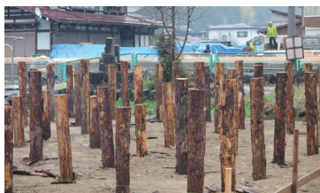
写真4 松杭による地盤改良
