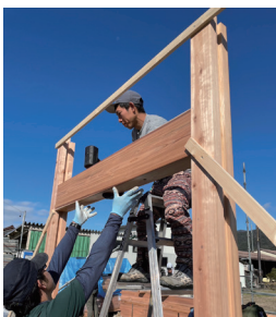
写真5 木材を上から落とし込む
