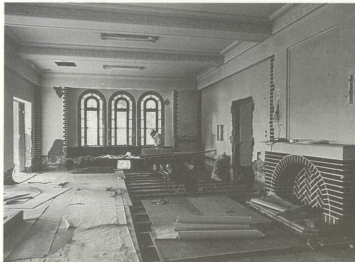
▲解体調査中の清風亭
