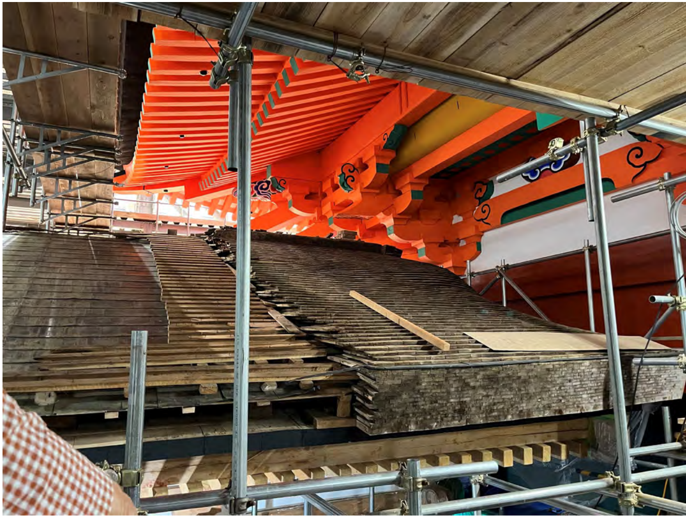
滋賀県文化財保護課本田主査による案内。 仮囲は鉄骨造。 檜皮葺きの葺き替え。
