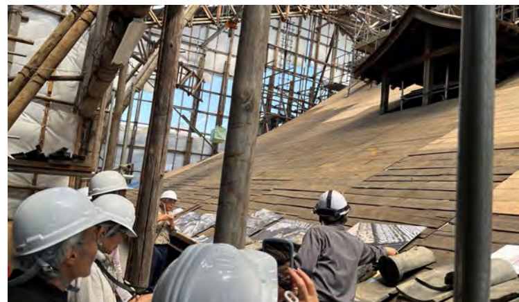
案内は妙法院大道執事庶務部長、京都府文化財保護課引間主査。仮囲いは在来の木組で伝統工法の継承を目的とする。
