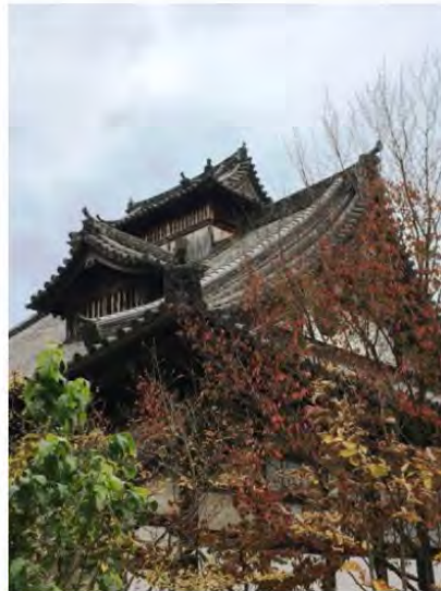
国宝『妙法院 庫裏』 屋根には排煙のため に小屋根が乗る
