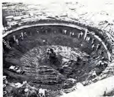
旧大劇場の回転舞台基礎下面が敷地前傾田畑の平均水面と略同じ位置となり、極の水位が上昇すると、その水圧で舞台が押し上げられる恐れのある事が判明。急遽舞台基礎の形状を橋脚に変更して数百トンの石を回転体基礎の下に重鎮として充填した。昭和39年(1964)11、12月号発行。(写真・図3)
