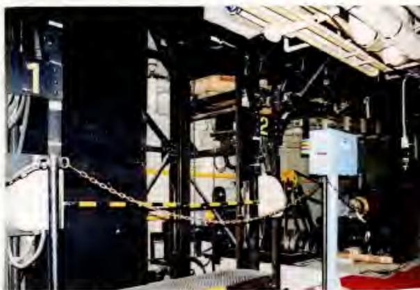
大劇場の花道・中奈落島屋連絡通路を下げられたスッコン。演者の乗り降り等の安全の為、進入遮断、監視カメラのための警成設備が装置にも設備された。
