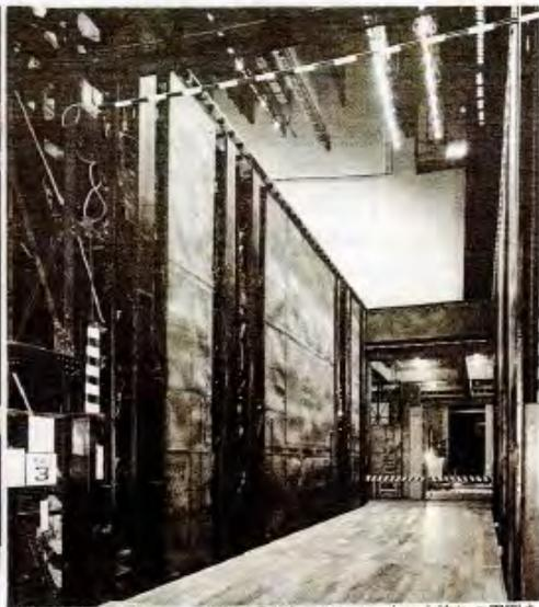
奈落に降りた大迫り。演者の「安全」のため、大・中迫りの周囲を有孔鉄板で囲み、迫りはその中で上下させる。劇場が開場した当初の頃は、迫り上の演者から「周囲が見えず自分が何処にきているのかも判らぬ、不安だ。常識外れの設計だ。」と強く批判され、極めて不評であった。三輪晃久写
