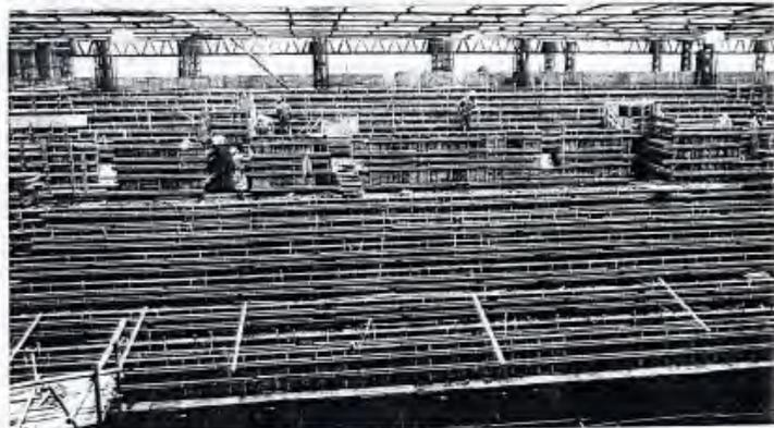
大劇場2階・3階席コンクリート仮枠及び配筋の施工中。昭和40年6月下旬
