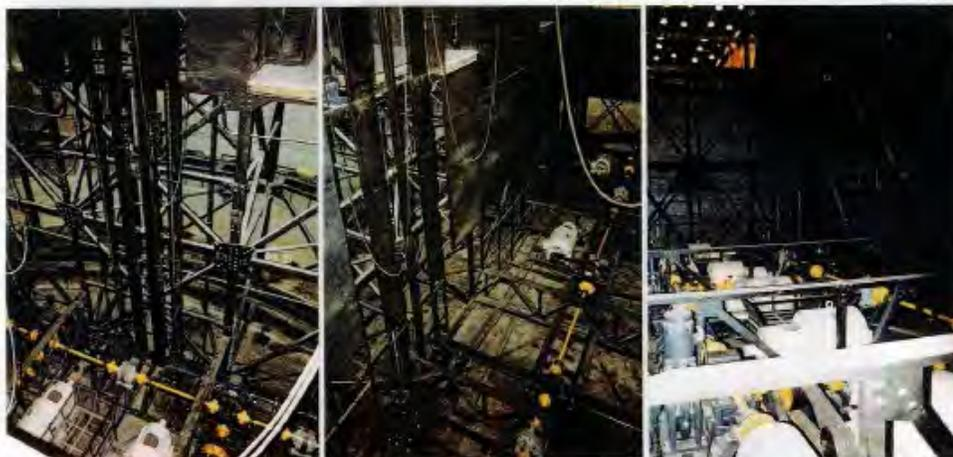
写真上：回転舞台（回り舞台）の作動中に演技者が奈落床から大セリ・小セリに乗り移る為の移動階段。舞台公演中は特に奈落空間全体が暗く、演者・舞台作業者は全ての動作に於いて極めて危険な状態に晒される。其の為、人の動作・機材・道具の安全を如何に得るか、を全ての設備の材質・構造の設計課題に帯えた。
