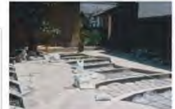
風の広場 コンクリート色出しによる風紋のデザイン
