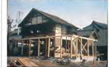
高山鶴山記念館は三度にわたり曳き家し、改修した
