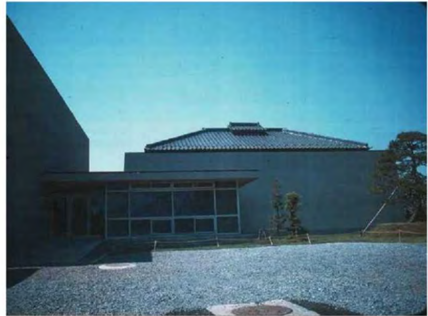
一期工事竣工時
