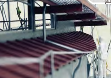
地上2階足場 浮遊する足場によって視線が抜ける
