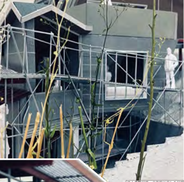
地上2階足場 立体的に交わる足場
