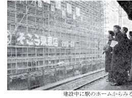
建設中に駅のホームからみる
