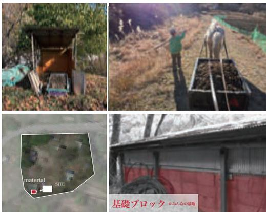
ブロック基礎を重ねて足場とした、ブロック基礎の間にある隙間に鉄筋足場のポールをさし、屋根を支える構造体とした。3つの分割された仕切りにタイミングがずれ合いながらも馬糞がうつされ、隣の場所に土を組む高さになる。
