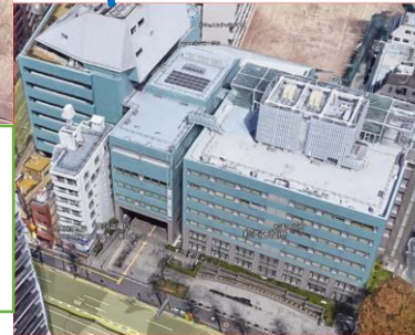
杉並区役所 10kW (2%自給) 0 m
