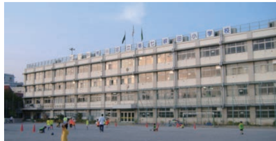
荒川区立第七峽田小学校・外観(改修前)
