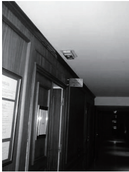
歴史的建築物のため、設置基準と異なる位置に取り付けた避難誘導灯（フランス）
