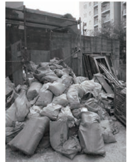
解体後のゴミの山
