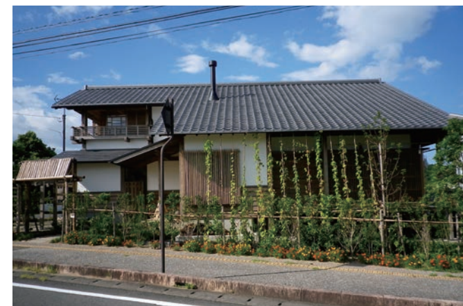
写真2：水俣市（熊本県）エコハウス 夏の外観 深い庇と大開口による涼風の取り入れ、蒸散作用も期待したグリーンカーテン。数年後には樹木や生け垣が成長して緑の豊かな庭になる。
