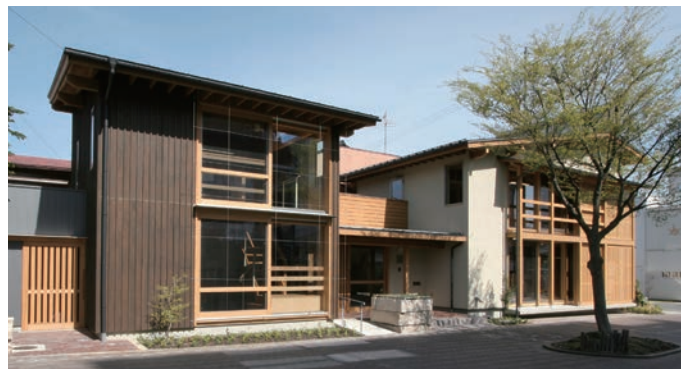
写真1：飯田市（長野県）エコハウス（撮影：設計者／新井優）南部分は子世代、右の北部分は親世代を想定した二世帯型住宅。地元の杉材を渡りアゴ構法で組み上げた高耐久な家づくり。南部分は三和土の土間床にチューブを埋め込み冬はベレットストーブの温熱を蓄熱。夏は夜間の冷風を直接送り土間蓄冷。北部分は冬の日射を活用したOMソーラーシステムで暖房エネルギーの60%を自給。補助暖房はベレットストーブ。東側のりんご並木を望む大開口は、冬は断熱障子、夏は格子戸や植生メッシュで寒さや日射に対応。住まい手による季節に応じた開閉で住み良い環境を創り出す。寒暖差の激しい内陸性盆地気候の南信州における市街地型エコハウス。
