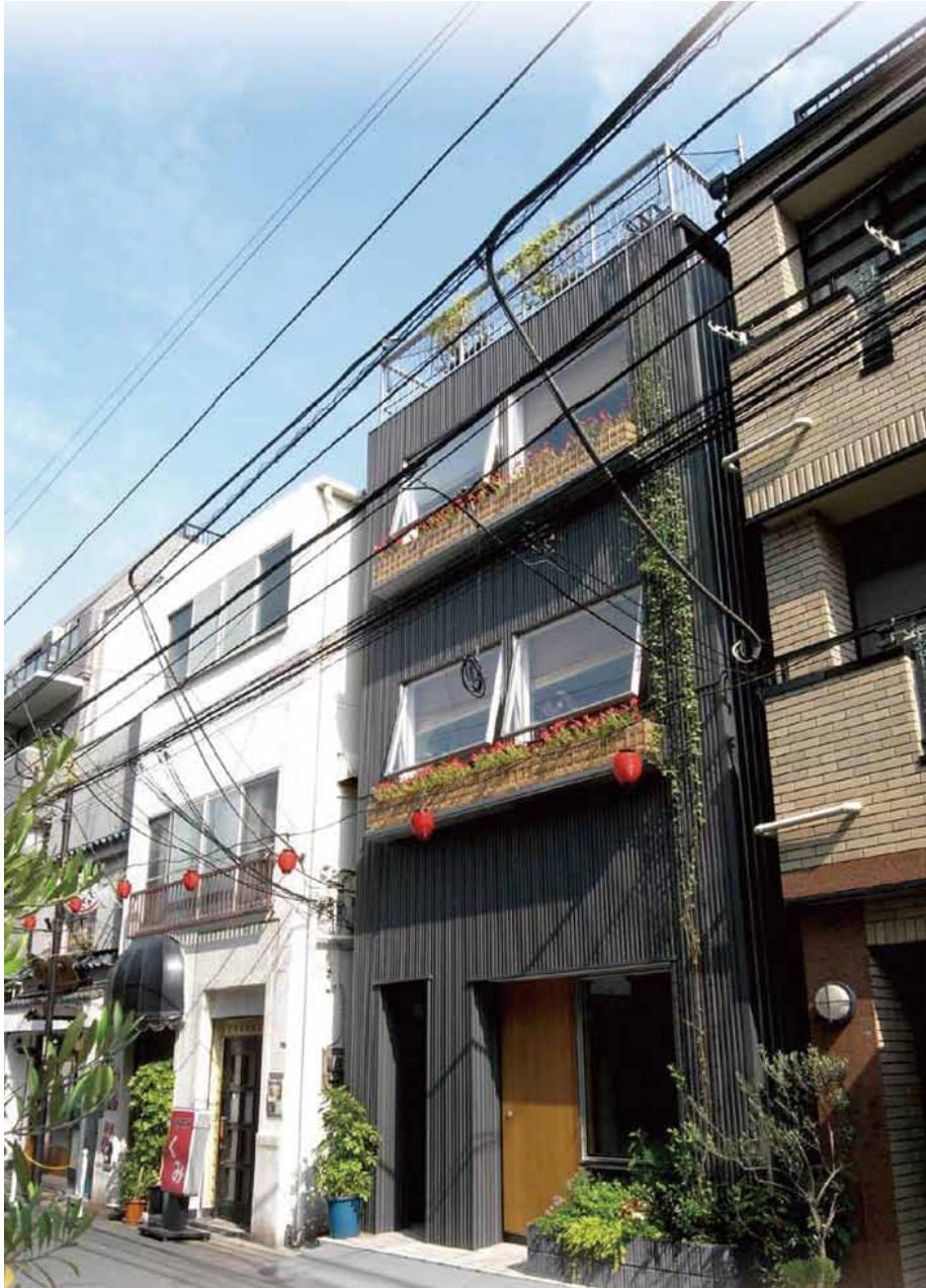
杉並区阿佐ヶ谷南 築33年鉄骨造建物 STUDIO TERAOS 断熱改修工事
